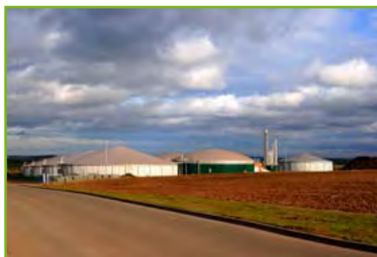
Biomethane plant in Könnern
