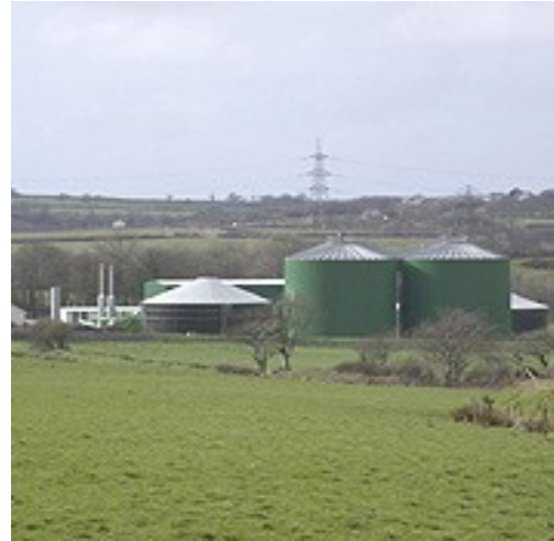
Impianto di Biogas a Holsworthy (Devon – UK)
